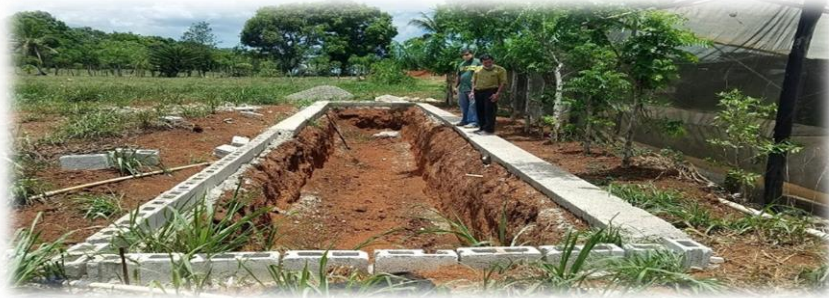
Fosa para el digester de Guanuma, Monte Plata
