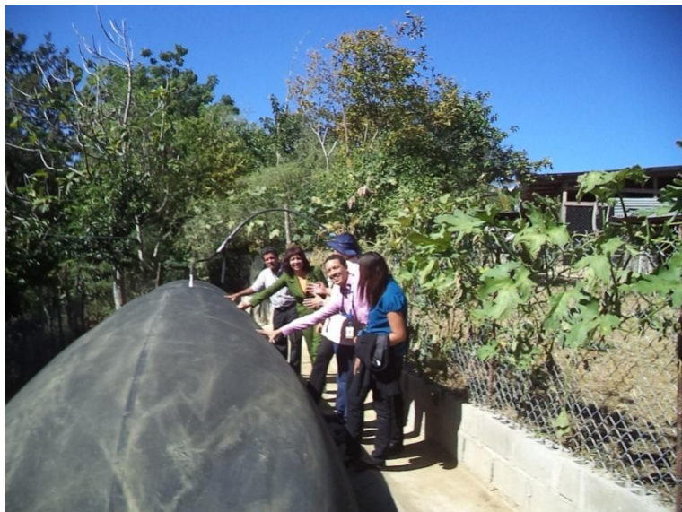
Foto 1 . Digestor del Monasterio lleno de gas metano. Al fondo, tanque de abono líquido (biol) y edificio de la cocina
