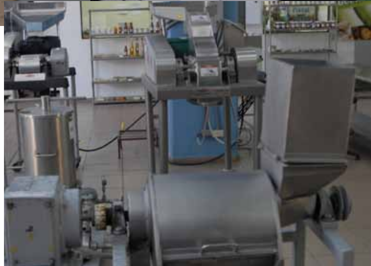
Remodelación de la Planta Piloto del Instituto.
