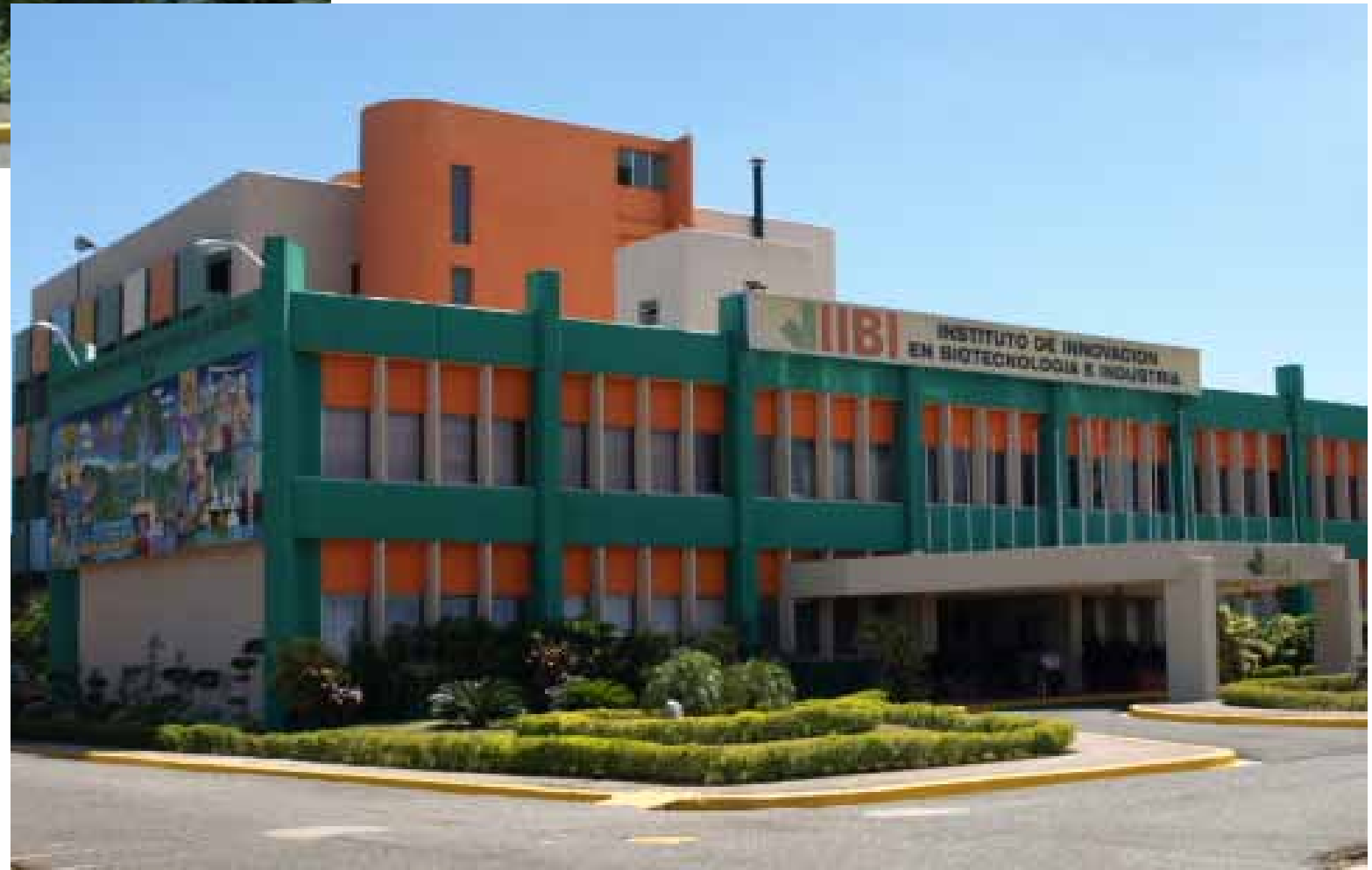
IIBI totalmente remodelado, 2012.
