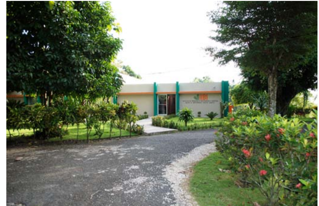
Fachada principal del Centro de Biotecnología Vegetal del IIBI
